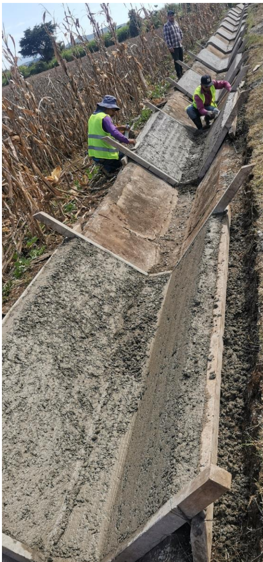
Construcción de pizarras y piso, en canal secundario existente.
