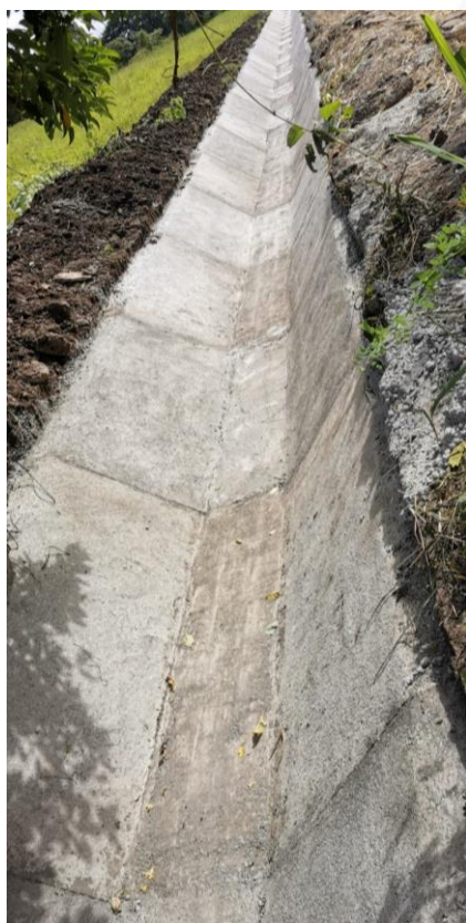
Mejoramiento de canal secundario con pizarras y piso conformando planchas con una sección aproximada de 3.00 por 2.00 metros de longitud.
